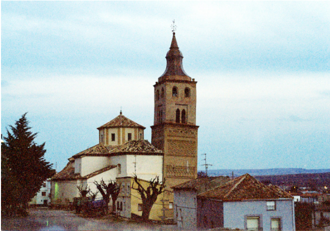
Vista general iglesia y torre
