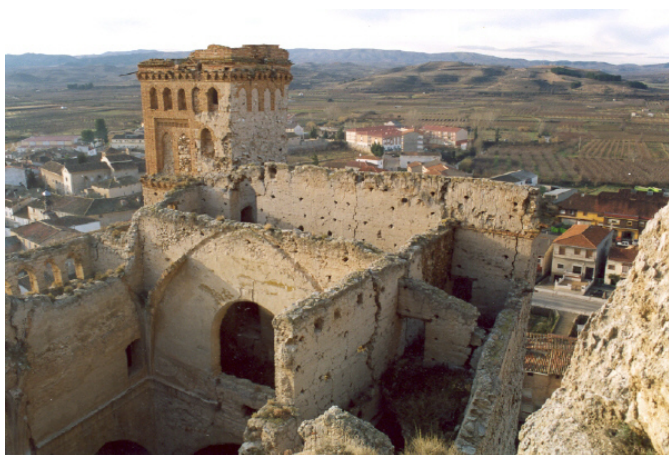
Vista zona superior sin cubierta
