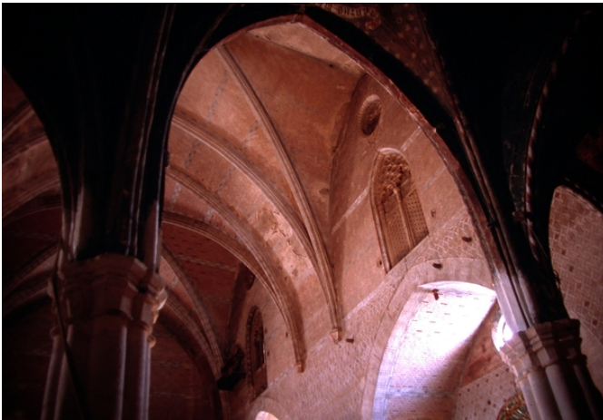
Vista interior desde las capillas del presbiterio
