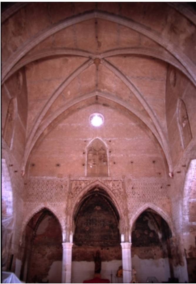
Capillas del testero en el interior
