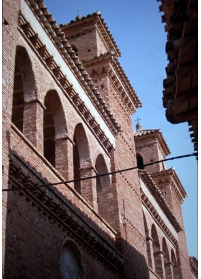
Vista exterior lateral
